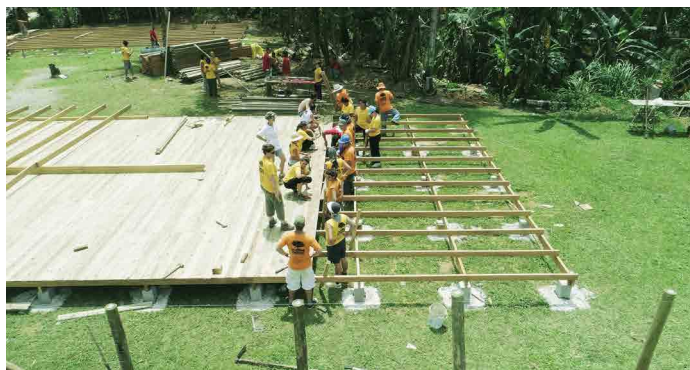
Mutirão para construção da escola
